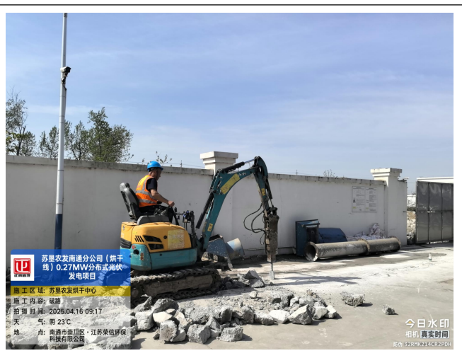
电缆沟破路
