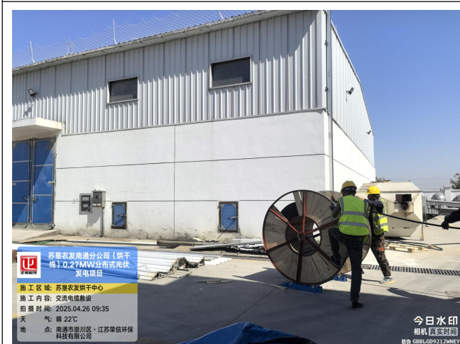
交流电缆敷设
