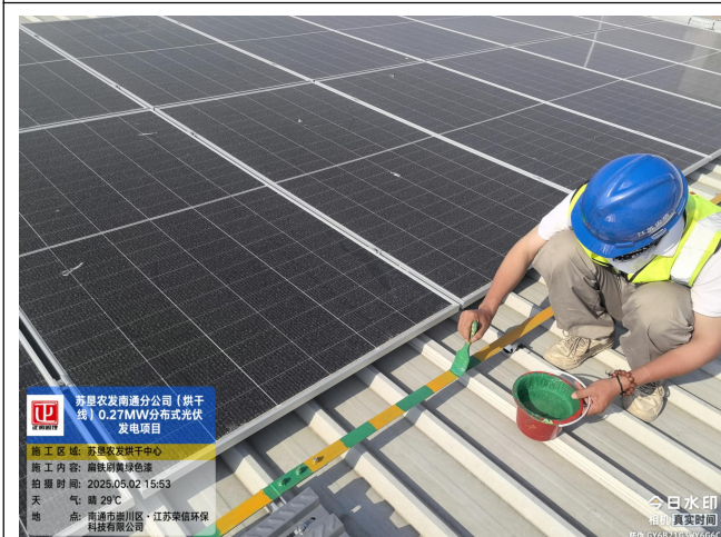
防雷接地施工
