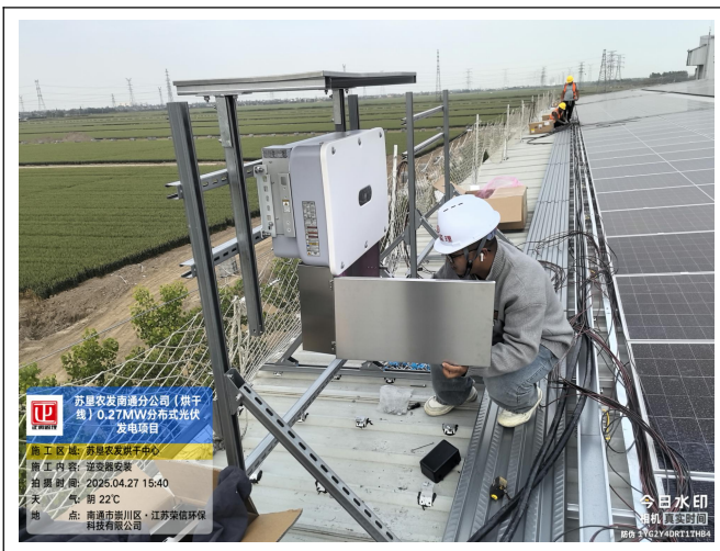
逆变器安装检查
