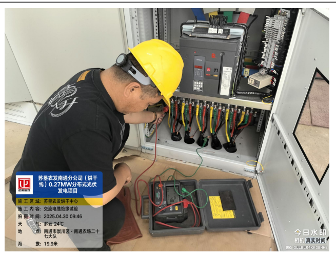
电缆绝缘试验
