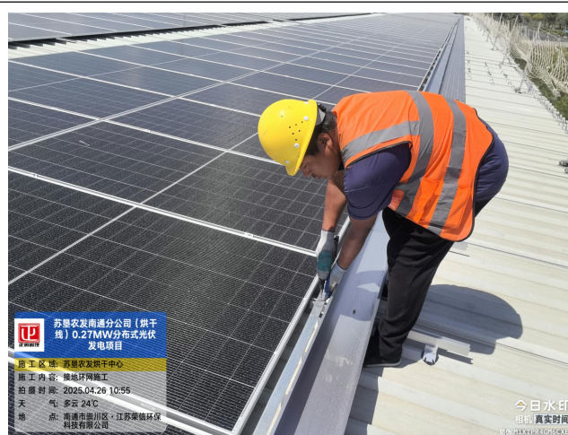
防雷接地施工
