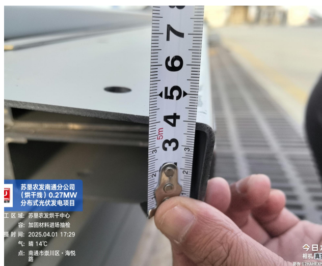
加固材料进场
