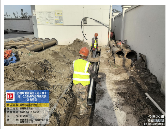
镀锌钢管敷设
