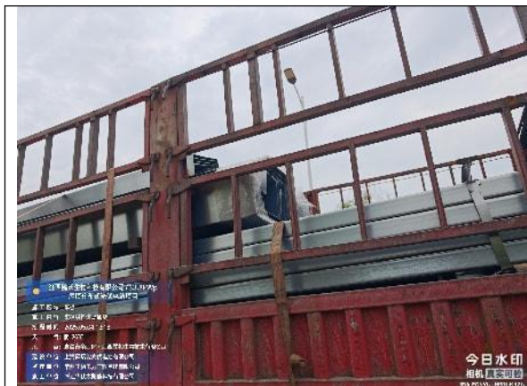
车棚钢结构安装
