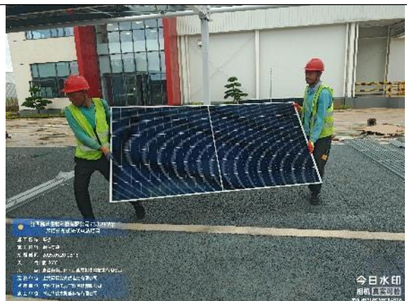
车棚钢结构调平
