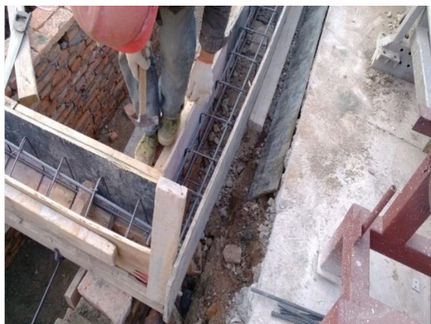
无基础放大垫层，容易下沉
