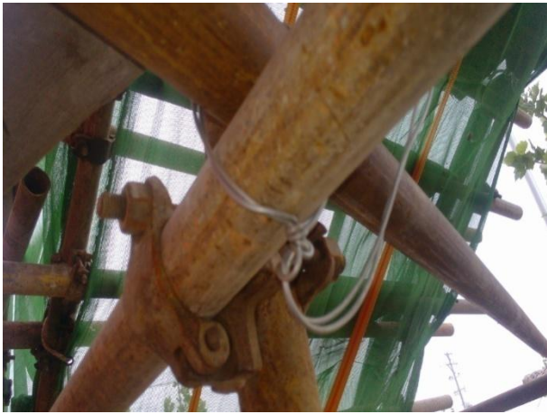
脚手架未用固定件连接，安全等级不够
