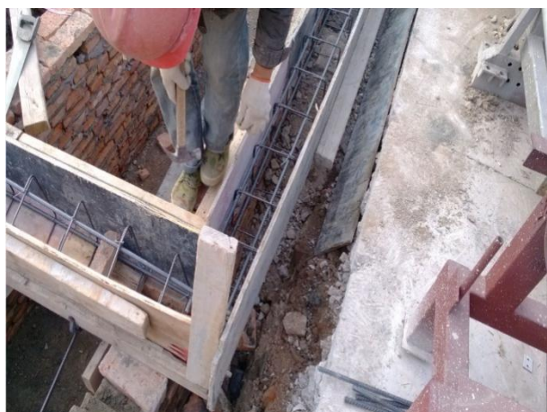
无基础放大垫层，容易下沉
