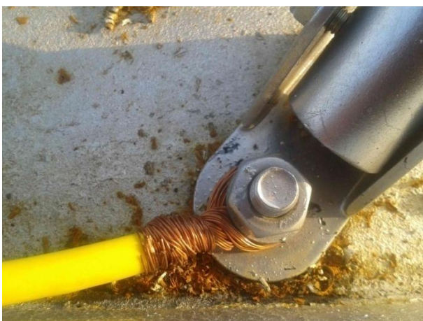
接地线不符合要求，存在漏电危险
