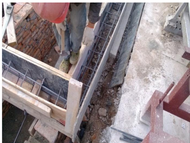
无基础放大垫层，容易下沉
