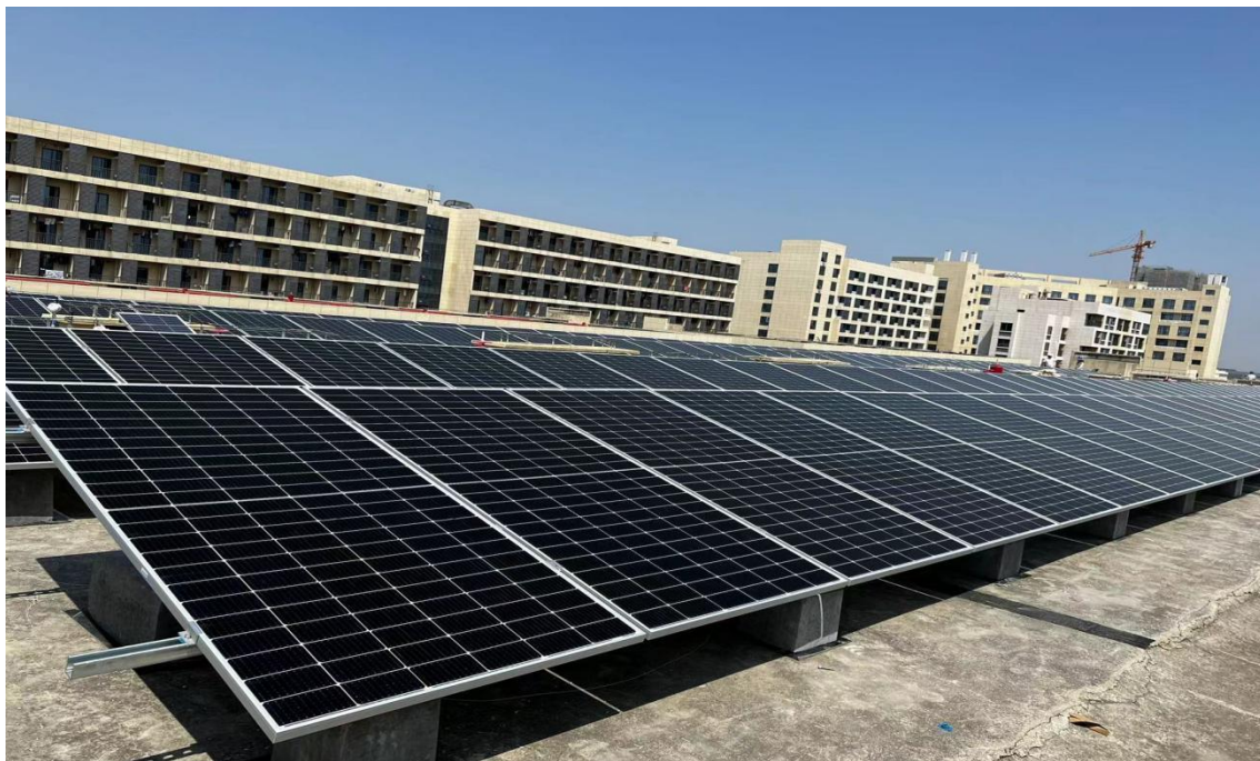
电站现场照片 1
