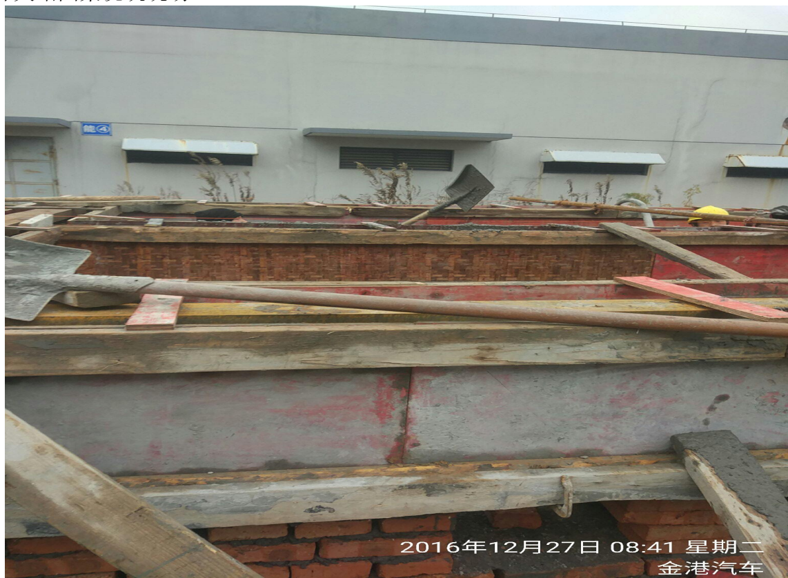
开关站圈梁浇筑现场：
