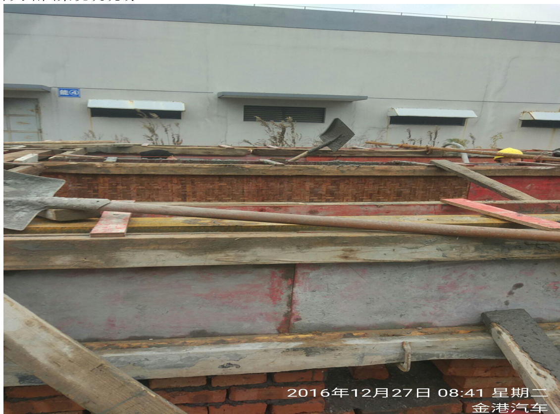
开关站圈梁浇筑现场：
