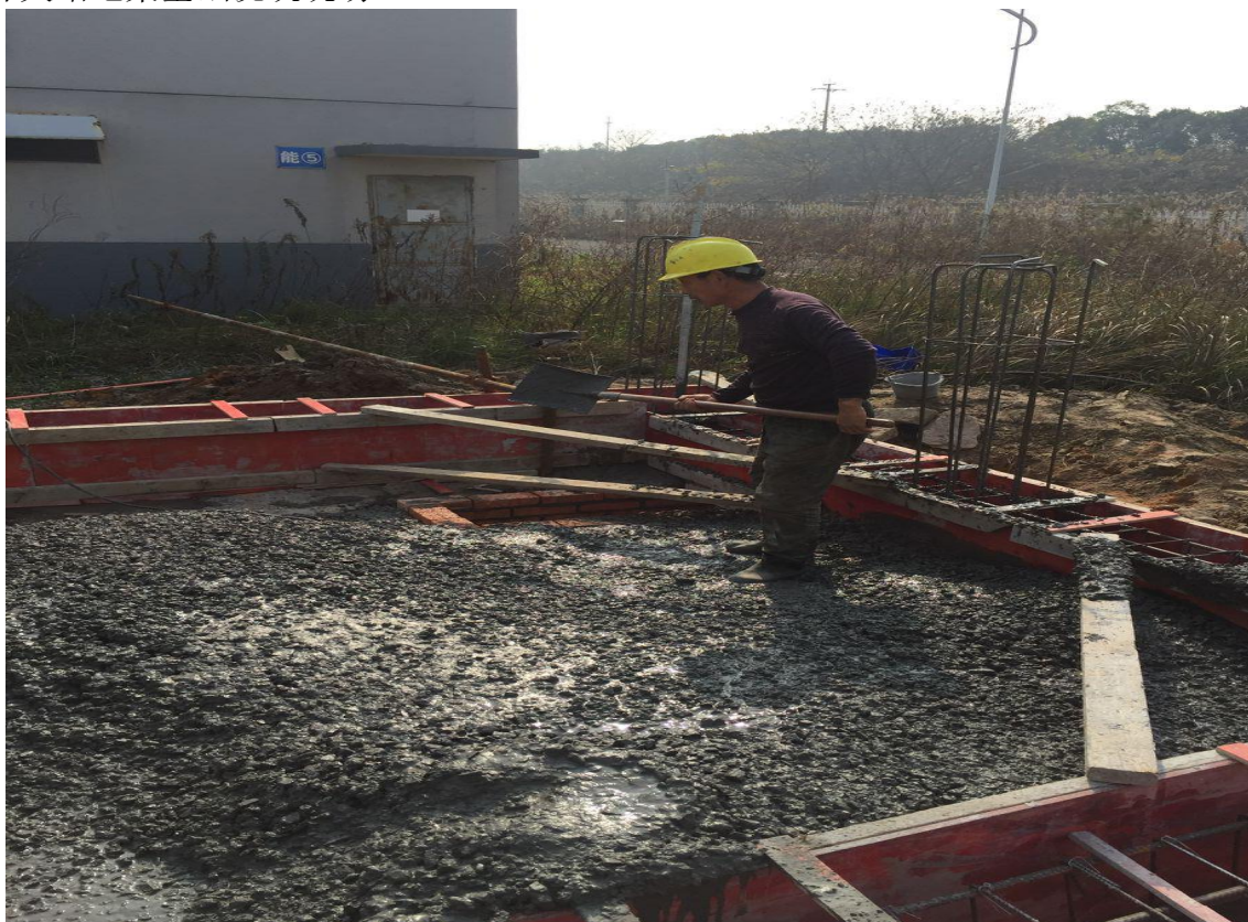
开关站地梁基础浇筑现场：
