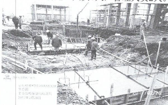
主变基础及构架基础砼浇筑旁站
