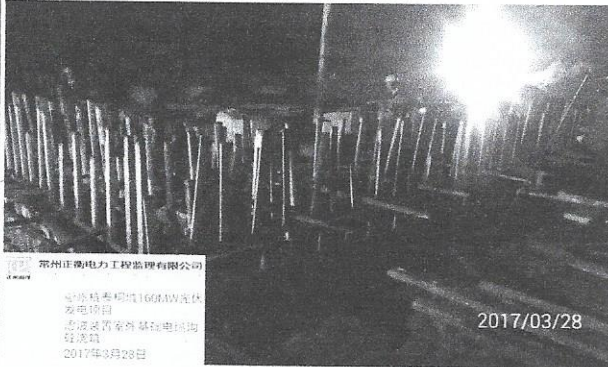
滤波装置室外基础电缆沟砼浇筑
