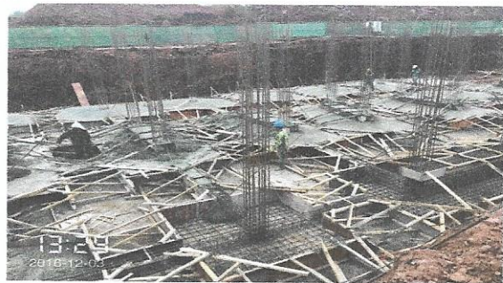
综合楼基础独立柱承台及基础梁浇筑
