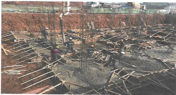
综合楼基础独立柱承台及基础梁浇筑
