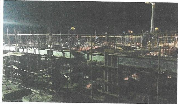
综合楼基础-0.05基础框架梁，柱浇筑旁站
