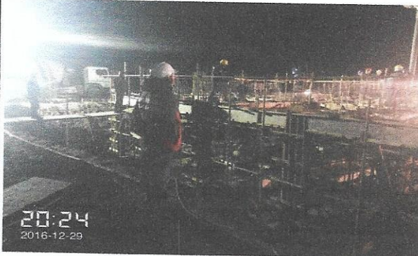
综合楼基础-0.05基础框架梁，柱浇筑旁站
