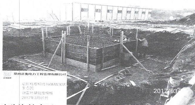
避雷针基础砼浇筑旁站
