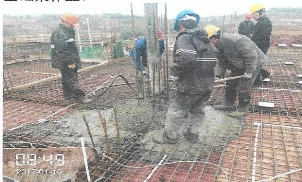
配电装置楼一层柱二层梁板浇筑
