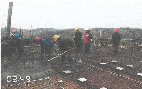
配电装置楼一层柱二层梁板浇筑
