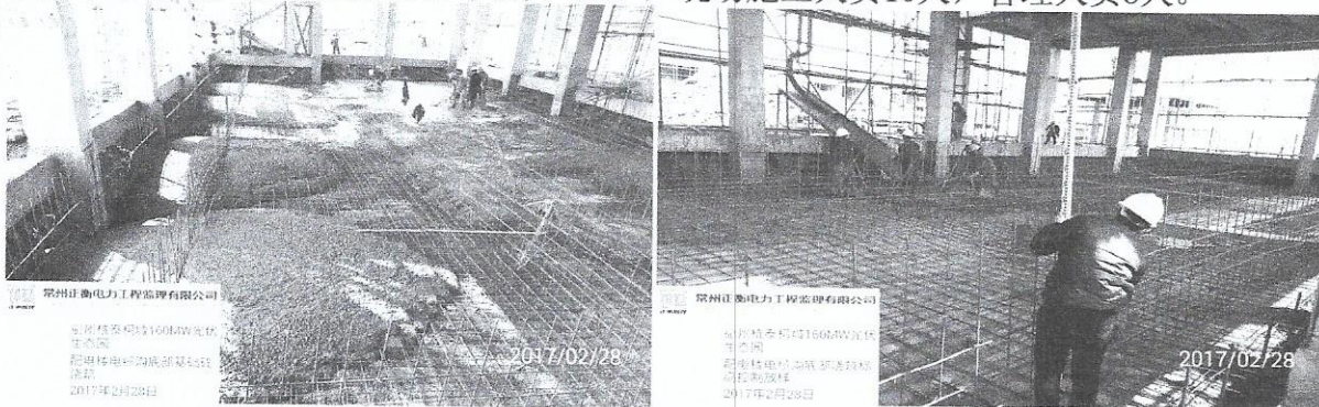
配电楼电缆沟底部基础砼浇筑旁站
