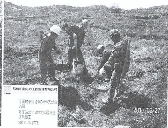
15MW光伏区桩基浇筑
