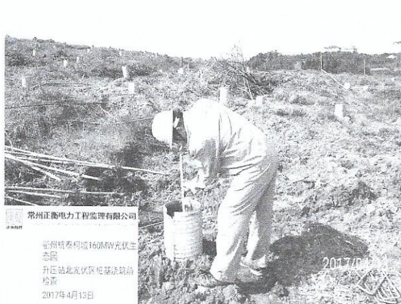
15MW光伏区桩基浇筑
