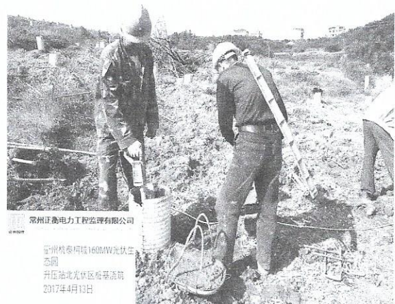
15MW光伏区桩基浇筑
