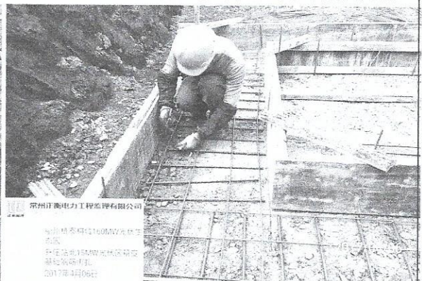
光伏区箱变基础承台浇筑
