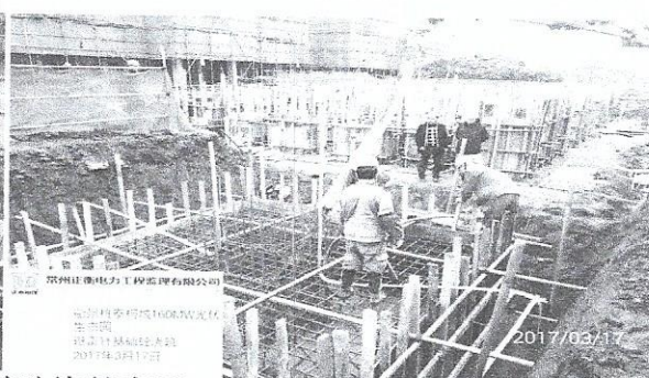
2#避雷针基础砼浇筑旁站
