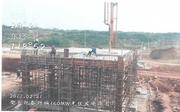
SVG1号、2号柱子梁板浇筑旁站
