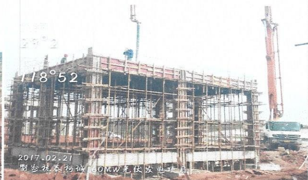
SVG1号、2号柱子梁板浇筑旁站
