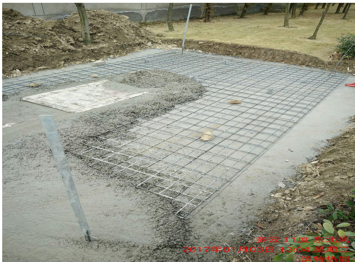
箱变基础浇筑现场:
