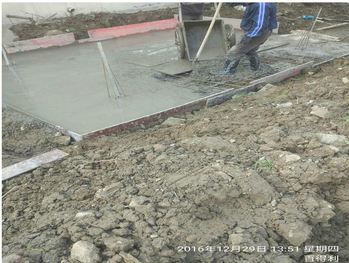
箱变逆变基础浇筑现场：
