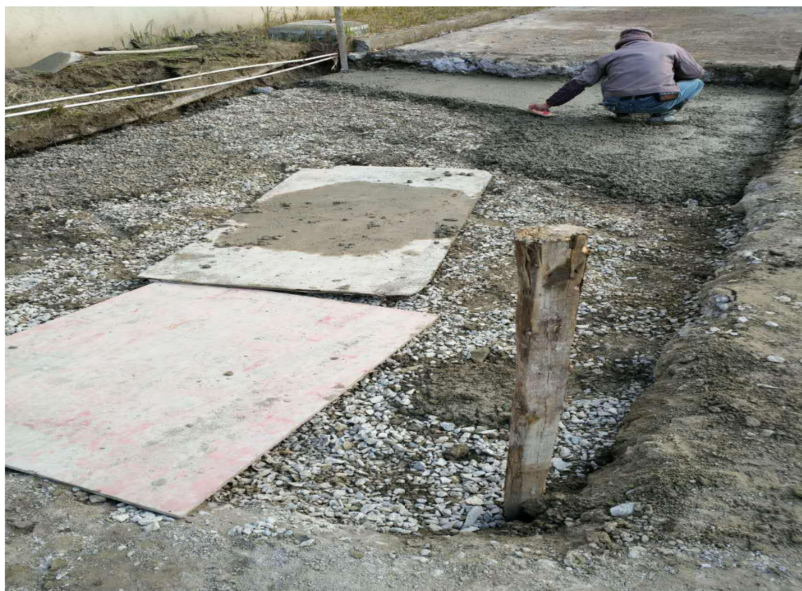
箱变逆变基础浇筑现场：
