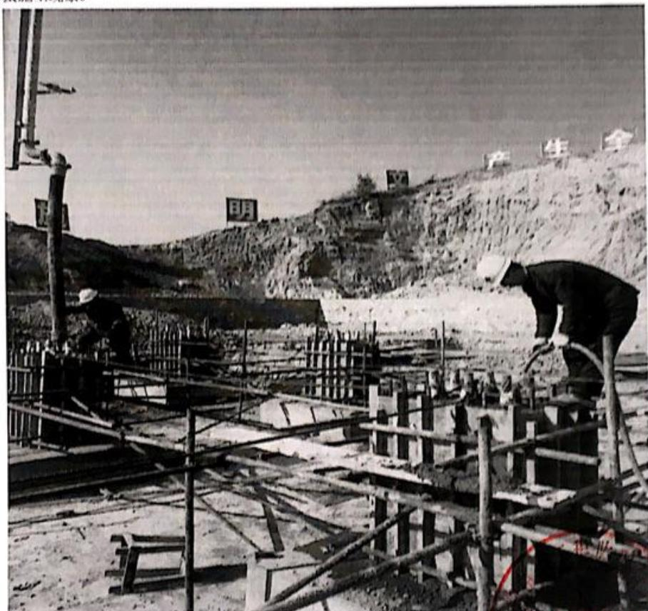
发现的问题及处理情况：现场部分立柱混凝土振捣不充分，已要求施工单位做好现场施工质量管
