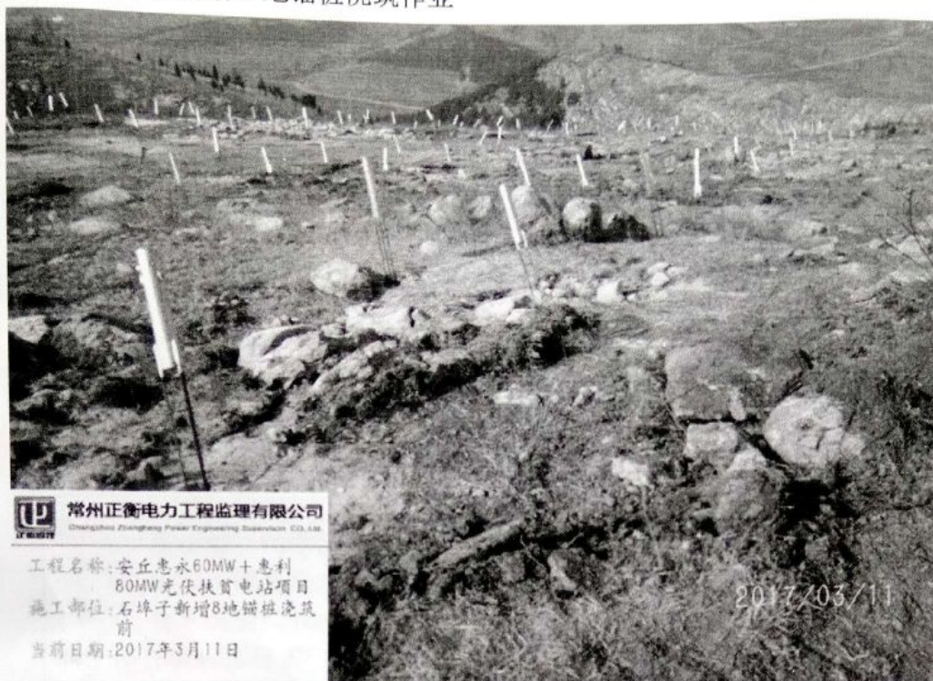
图一：石埠子新增 8 地锚桩浇筑作业
