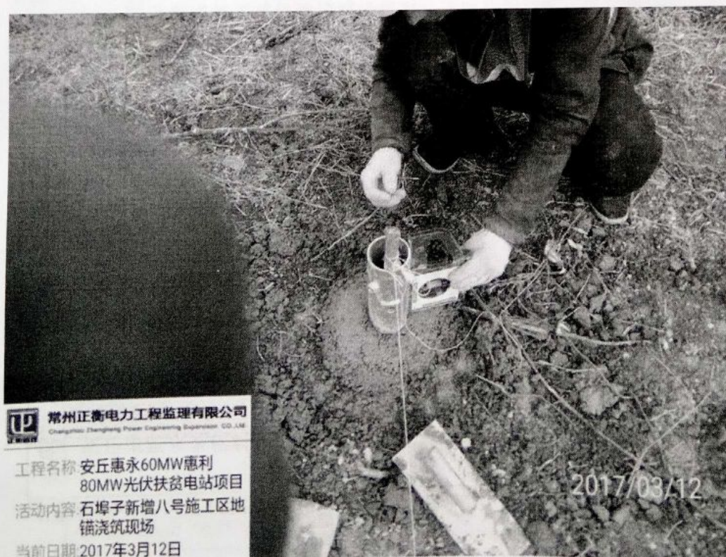
图二：石埠子新增 8 地锚桩浇筑作业
