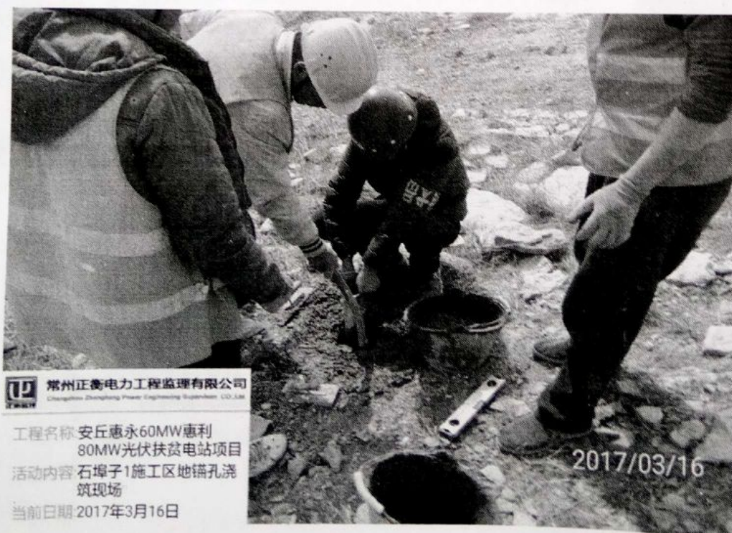
图二：石埠子1地锚桩浇筑作业
