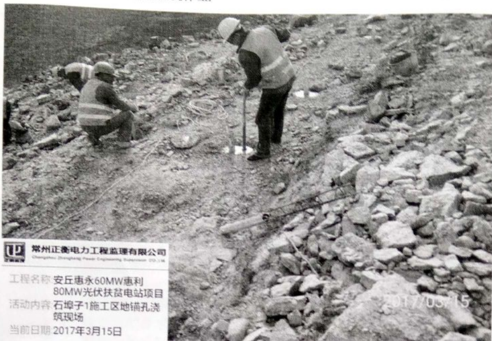
图一：石埠子1地锚桩浇筑作业
