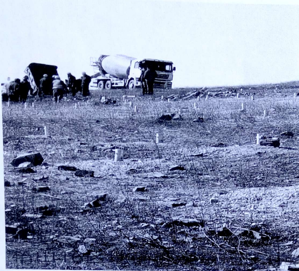
图一：柘山 16 地锚桩浇筑过程中
