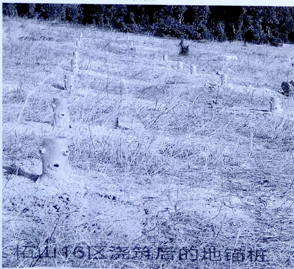
图二：柘山 16 区地锚桩浇筑完成后
