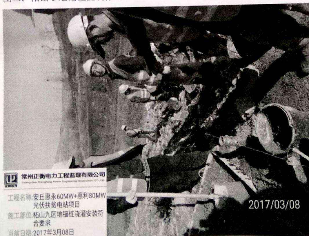
图二：柘山9 地锚桩浇筑作业
