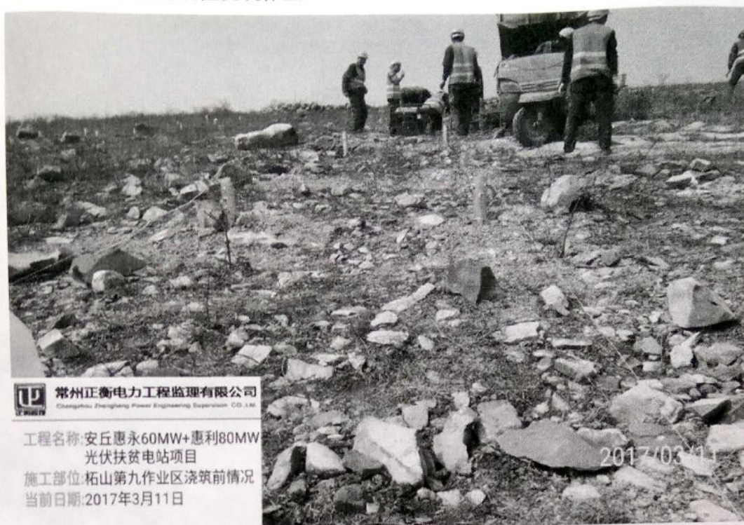
图一：柘山 11 地锚桩浇筑作业
