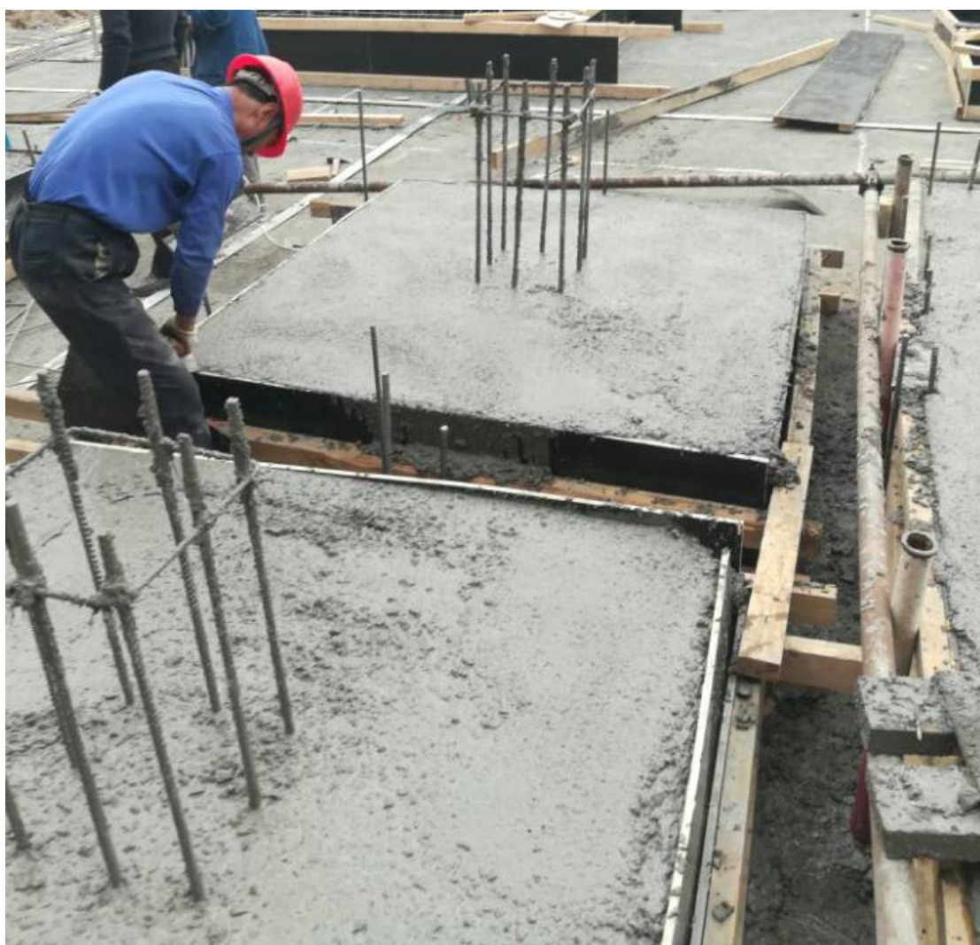
SVG 基础承台浇筑。
