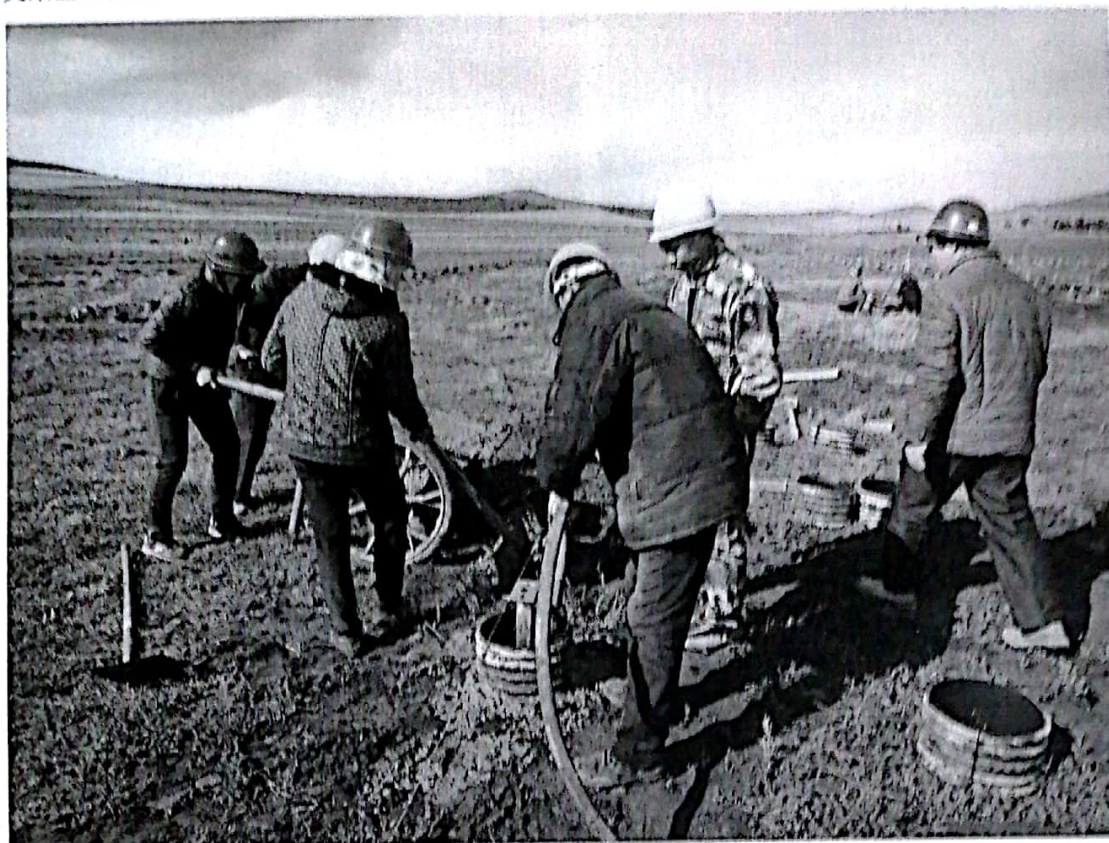
支架基础浇筑完成后检查
