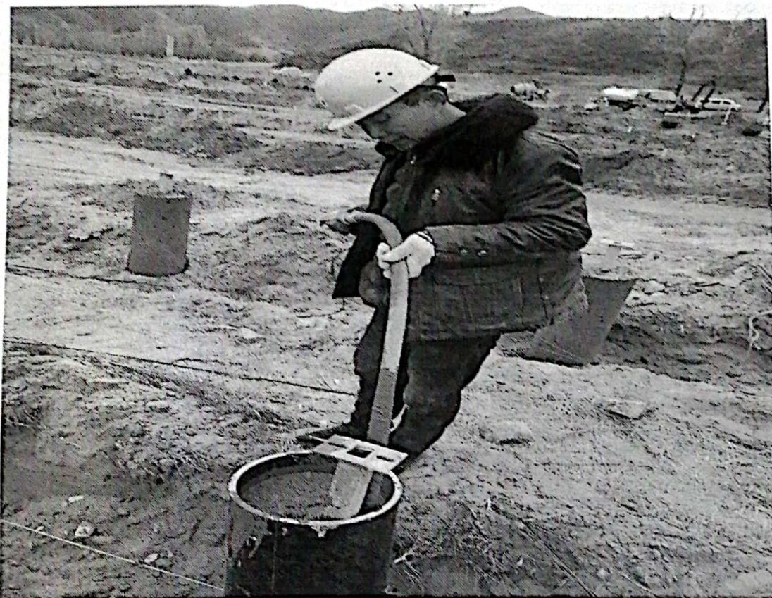
支架基础浇筑完成后检查
