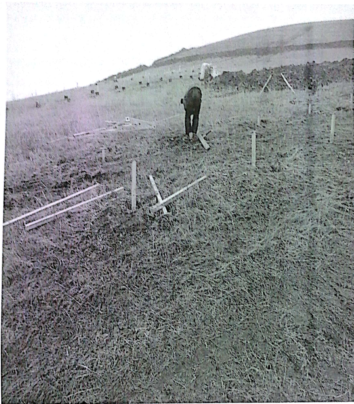
支架基础浇筑
