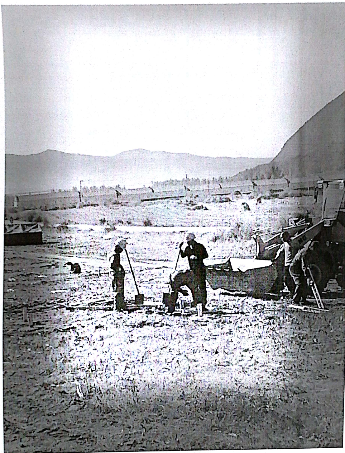
支架基础浇筑
