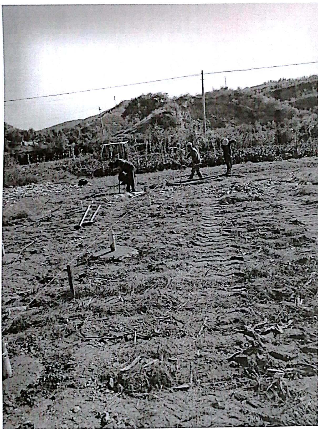
支架基础浇筑
