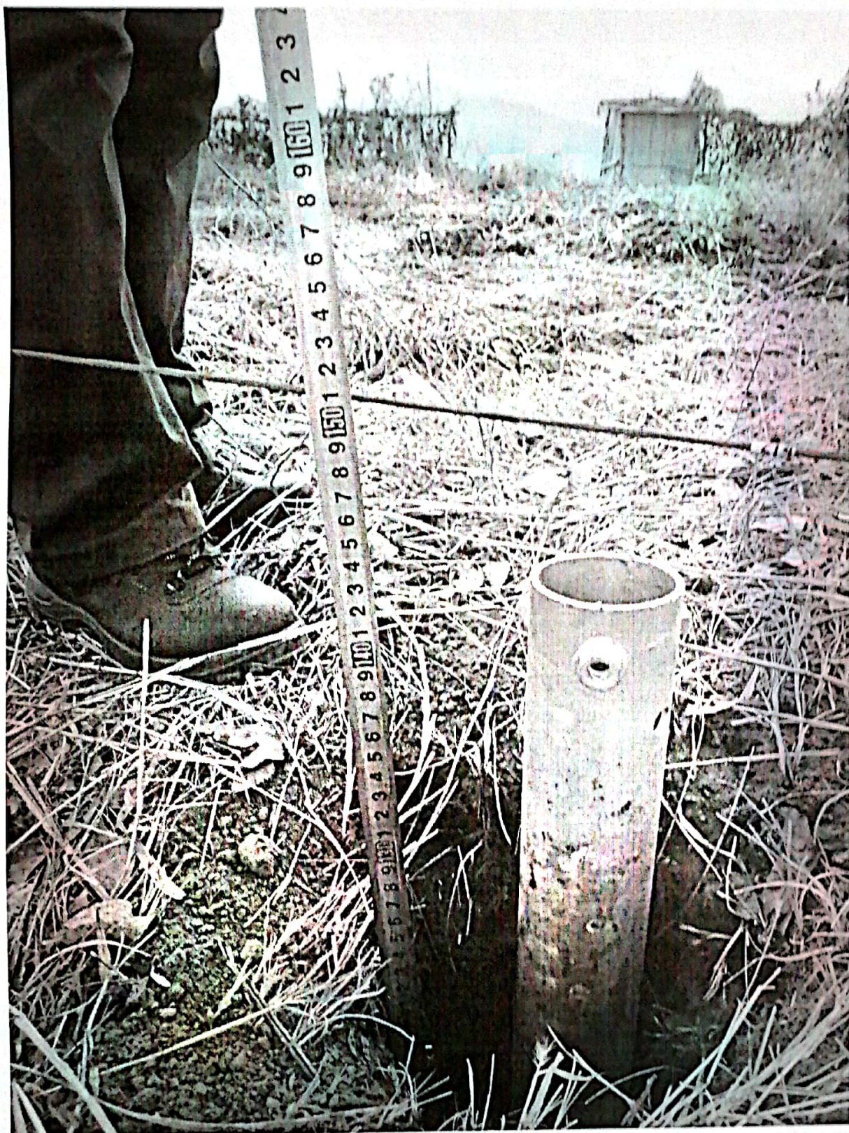
支架基础浇筑
