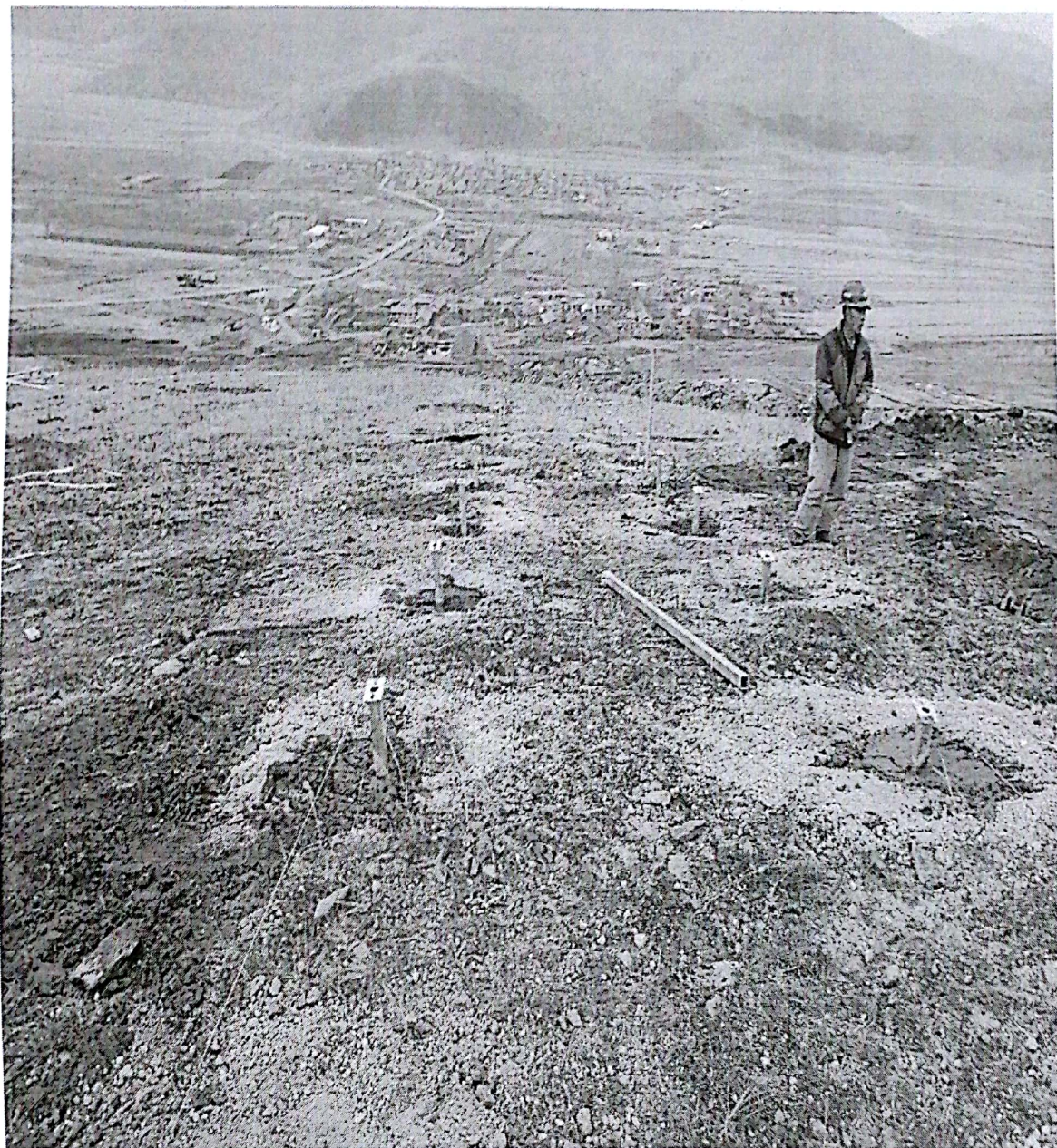
支架基础浇筑
