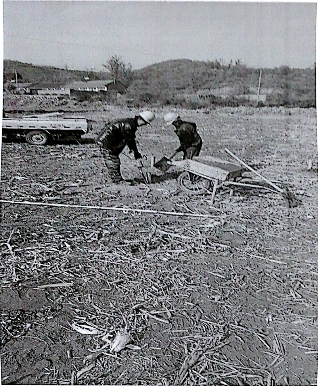
支架基础浇筑
