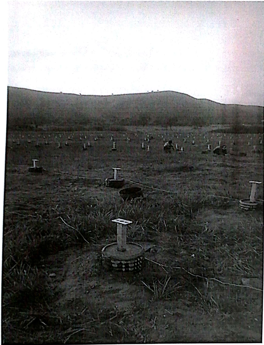
支架基础浇筑
