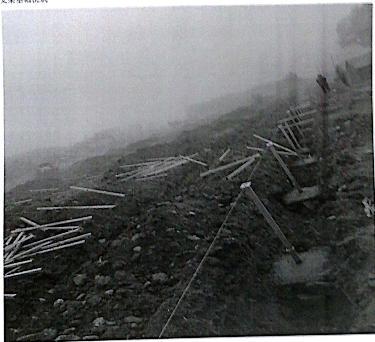
支架基础浇筑
