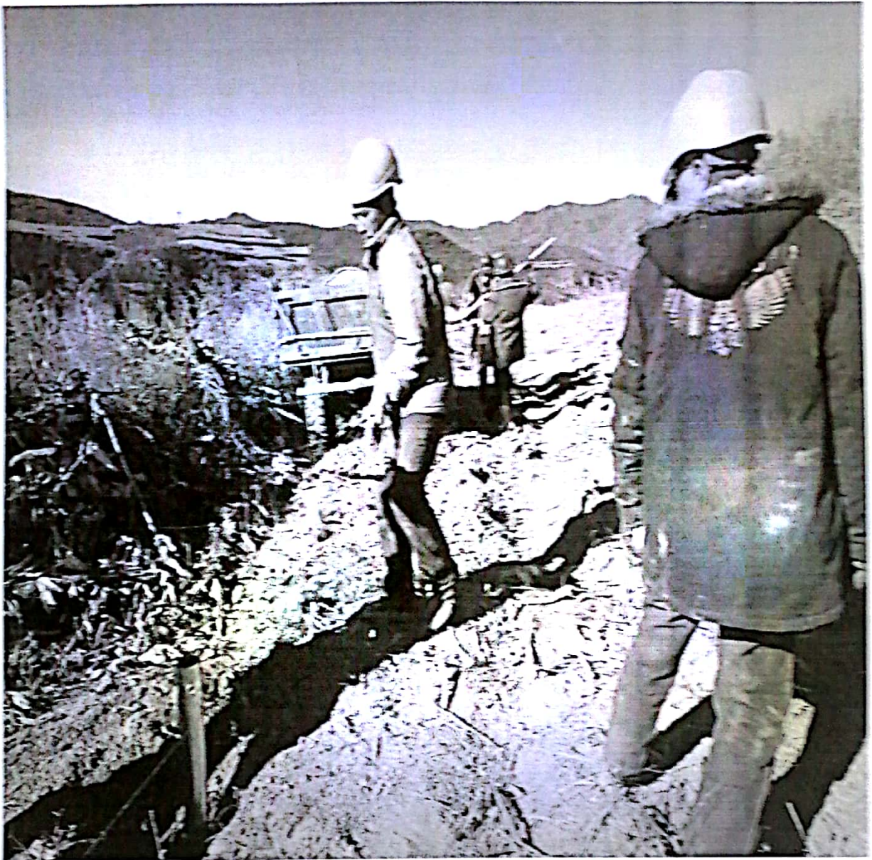
支架基础浇筑
