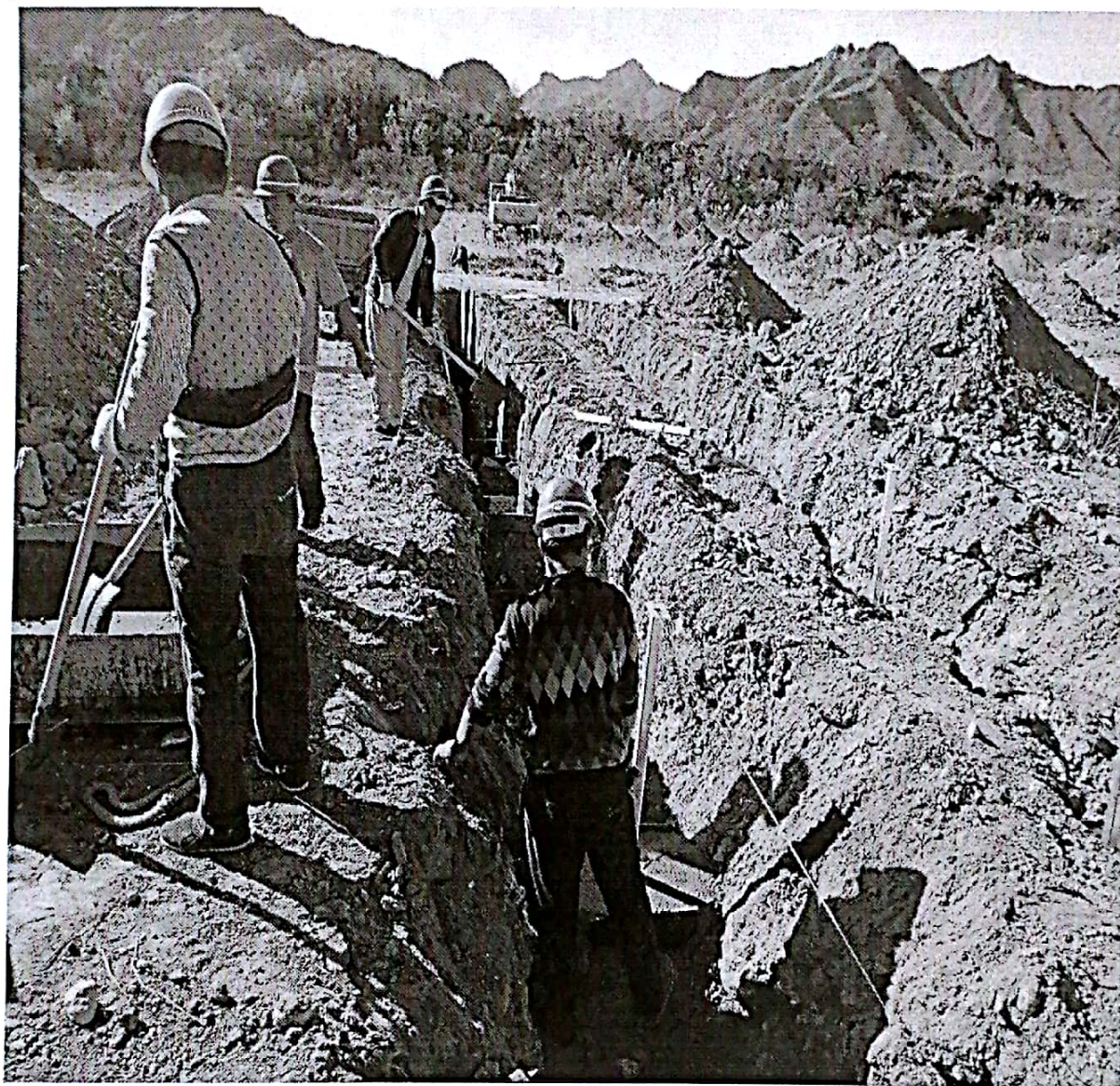
支架基础浇筑
