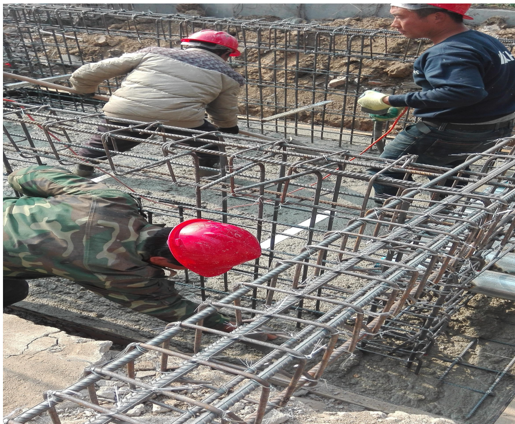
5 号箱变基础底板浇筑
