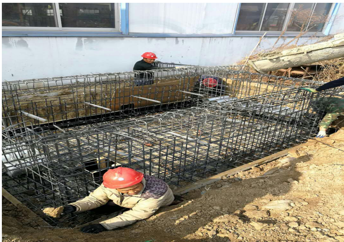
5 号箱变基础底板浇筑
