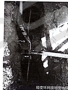
箱变环网接地接地极
