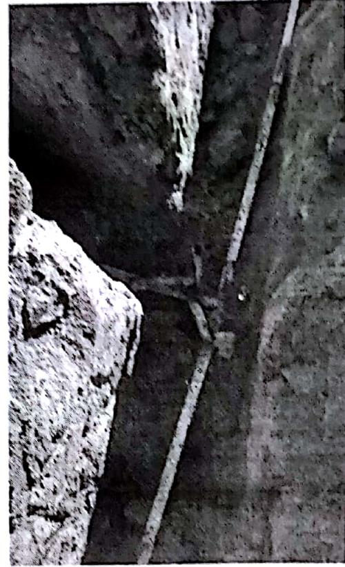
施工人员按照图纸要求和规范，进行下料，然后进行焊接作业。搭焊接长度不少于扁钢宽度的 2 倍，并且三个棱边进行焊接，焊缝平整、饱满、牢固，符合设计要求。要求焊接完成后做好防腐工作。
