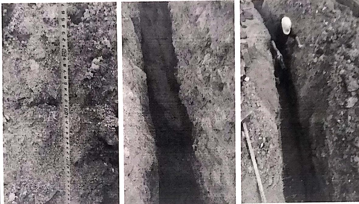
施工人员按照图纸设计和规范要求，首先清除沟内杂物及石块，以免损伤电缆。然后铺上细沙平整好，盖好砖，最后进行回填压实，沟内无杂物。施工过程符合要求。
