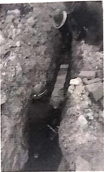
施工人员按照图纸设计和规范要求，首先清除沟内杂物及石块，以免损伤电缆。然后铺上细沙平整好，盖好砖，最后进行回填压实，沟内无杂物。施工过程符合要求。
