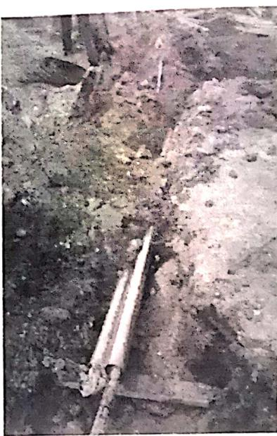
施工人员按照图纸设计和规范要求，首先清除沟内杂物及石块，道路交叉处敷设于保护钢管内，以免损伤电缆。然后铺上细沙平整好，盖好砖，最后进行回填压实，沟内无杂物。施工过程符合要求。
