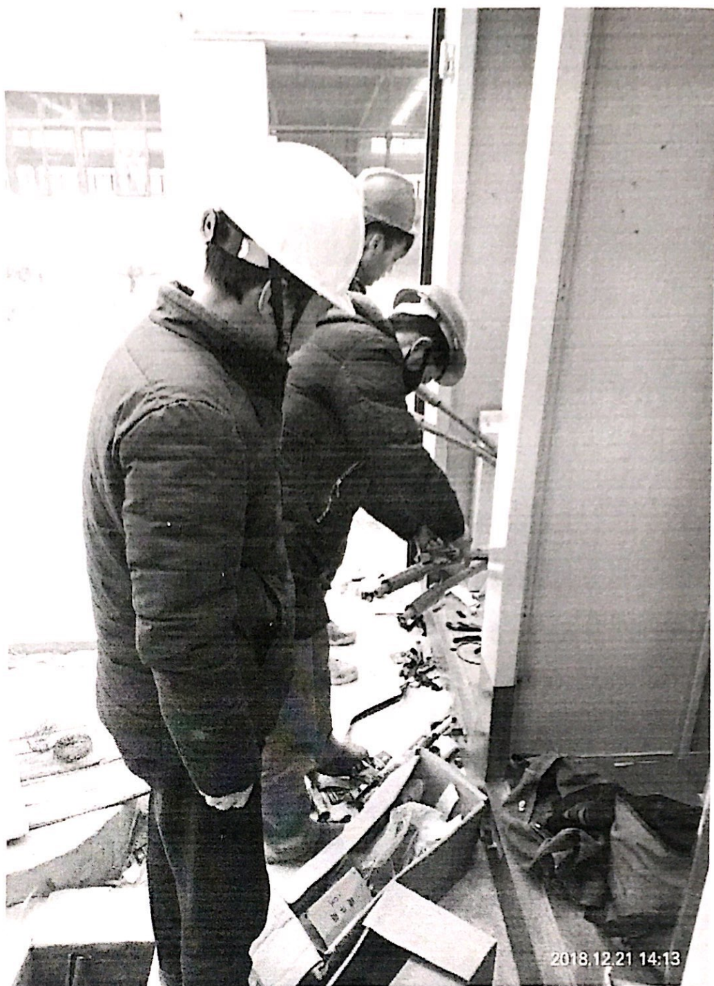
箱变电缆头制作监理旁站
